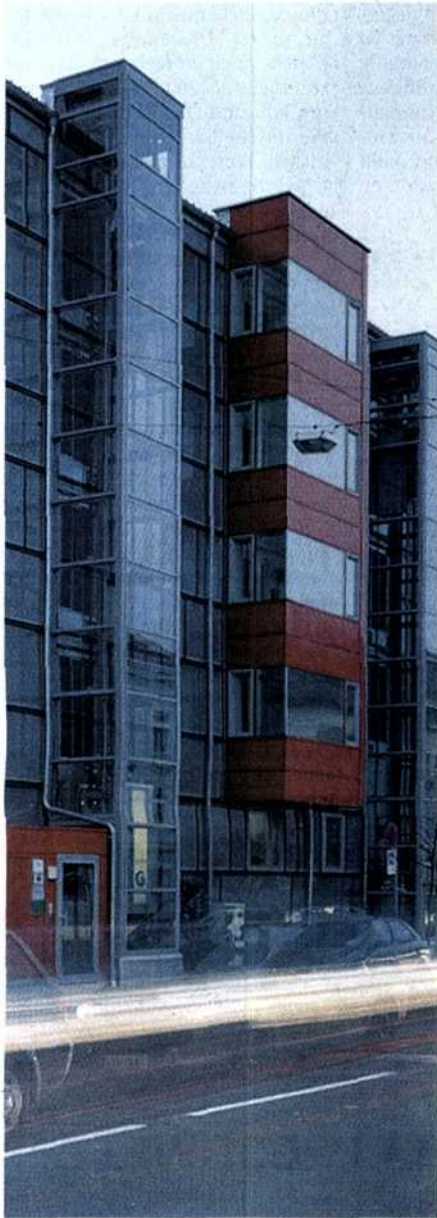
In der Linzer Makartstraße konnten die Heizkosten durch eine hinterlüftete Solarfassade stark gesenkt werden.
